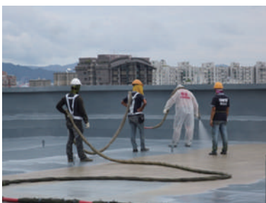
飯店屋頂施工
