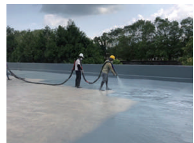
醫院屋頂施工
