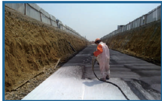
噴塗速凝橡膠防水塗料施工
