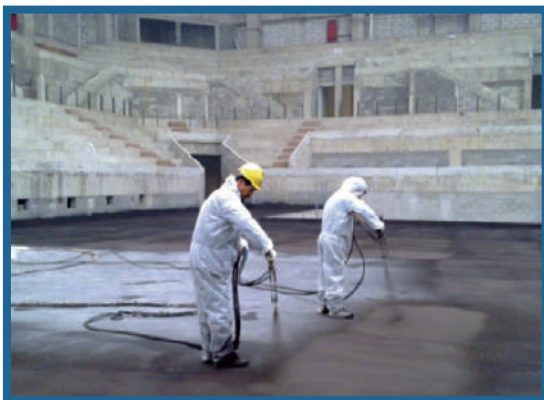
噴塗速凝橡膠防水塗料施工
