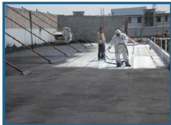
噴塗速凝橡膠防水塗料施工
