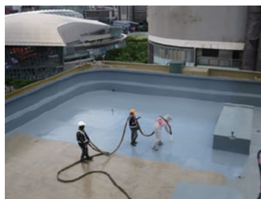
飯店屋頂施工
