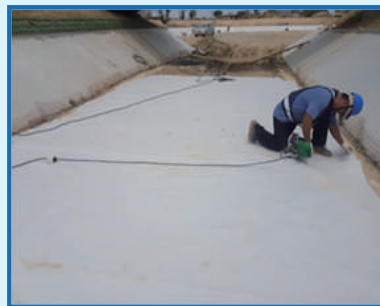
大底底部防水膜鋪設焊接
