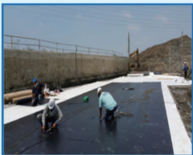
保護不織布、防水膜鋪設搭接
