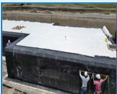
防水膜、保護不織布包覆雨水積磚
