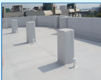
水泥墩座施工
