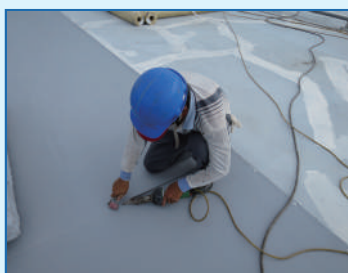
PVC防水膜鎔槍焊接
