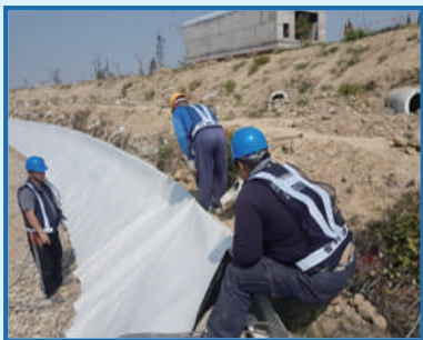
大湖底部防水膜鋪設
