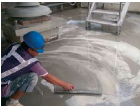
台北王朝大酒店 地下室、屋頂工程使用亞力士BESTONE水泥基滲透結晶防水材料
