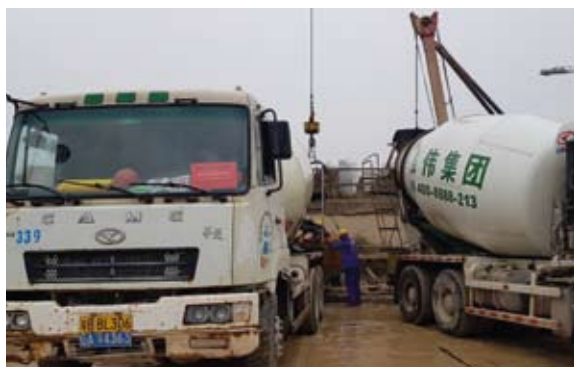
■ 海南省三亞市海上觀音地下工程 海中基礎地板、梁、承台使用 BESTONE A內摻天然無機活性抗裂 自癒矽質系防水混和材
