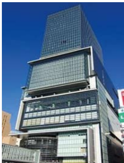
澁穀ヒカリエ——地下工程
