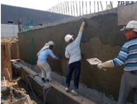
台南富士電子廠 外牆工程使用亞力士BESTONE水泥基滲透結晶防水材料
