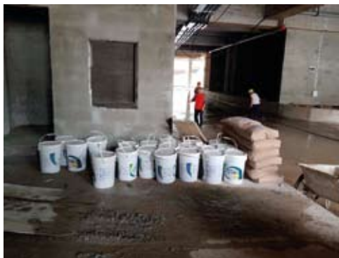
■ 深圳紅山商業中心項目 地下室底板使用亞力士BESTONE水泥基滲透結晶防水材
