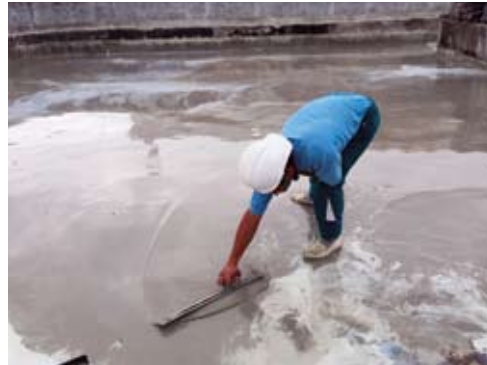
台北王朝大酒店 地下室、屋頂工程使用亞力士BESTONE水泥基滲透結晶防水材料
