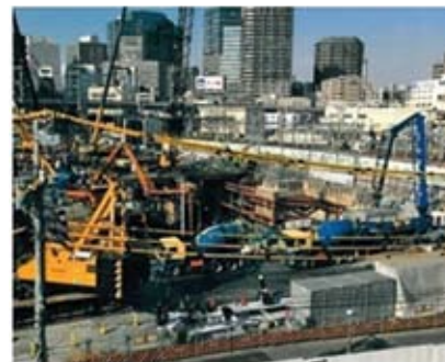
6 地下工程灌漿防水施工
