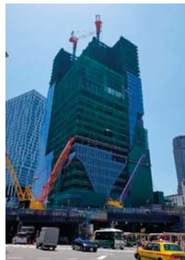
東京涉谷車站街区東棟新建築工事—— 地下工程
