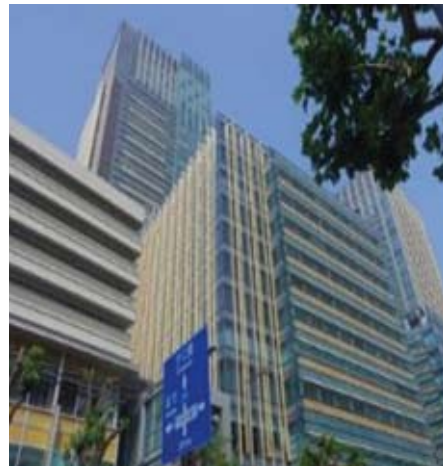
東京ミッドタウン——地下工程
