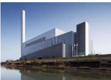
東澱清掃工廠—地下工程
