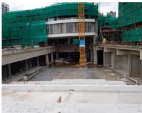
■ 深圳紅山商業中心項目 地下室底板使用亞力士BESTONE水泥基滲透結晶防水材
