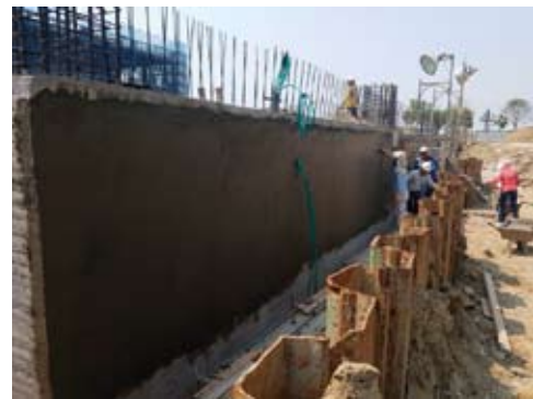
台南富士電子廠 外牆工程使用亞力士BESTONE水泥基滲透結晶防水材料
