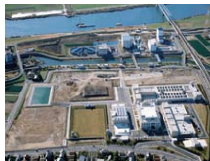
ちば野菊の裡浄水場—上下水道・水槽・排水施設
