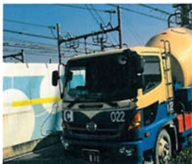
5 混凝土車到工地
